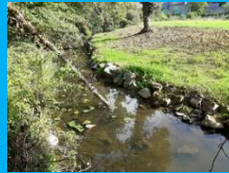
Resserrement du lit d'étiage – Ille à Saint Germain sur Ille
